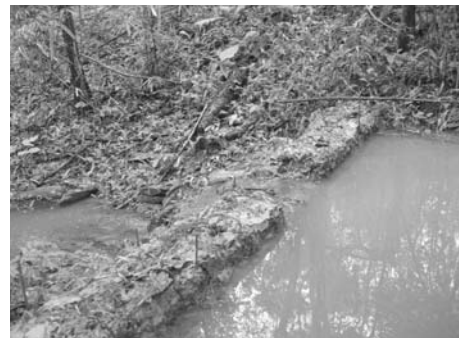
「一つ一つは小さいけれど、多くの人命を救う雨季で水かさの増したチェックダム」
