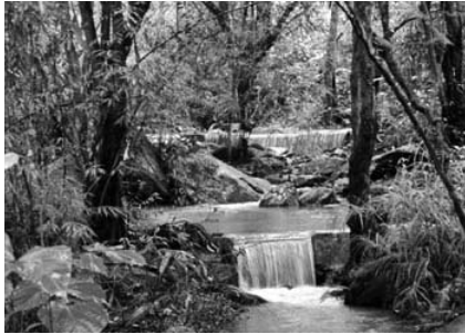
鉄砲水等洪水の防止に役立っている2機のダム
