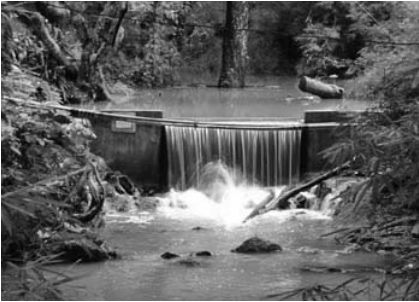
ドイステープ地区に完成したチェックダム
