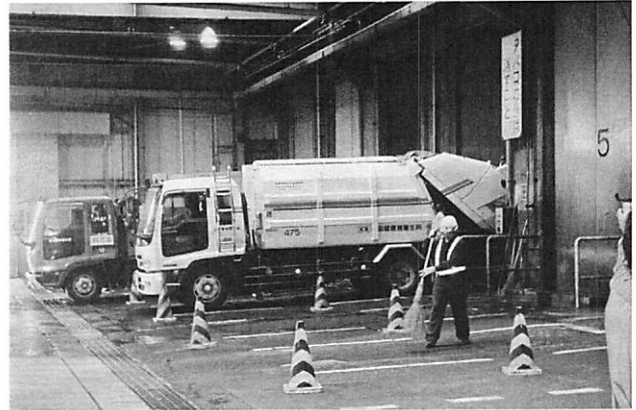
ごみ投入プラットフォーム
