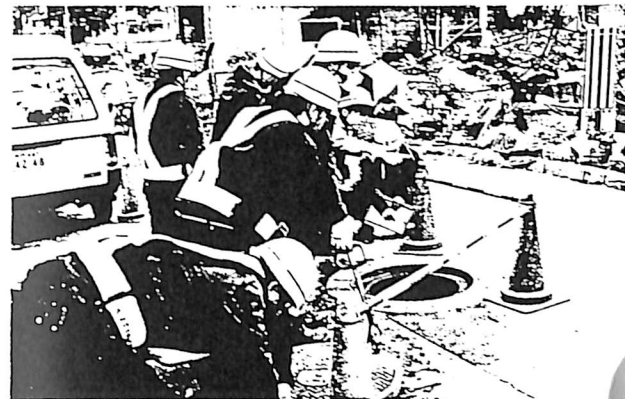
加入者系通信ケーブルの復旧には、ケーブルの経路をまず確認しなければならない。
